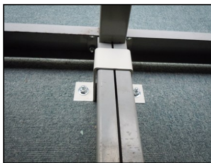
【対策①：書架の床固定】
