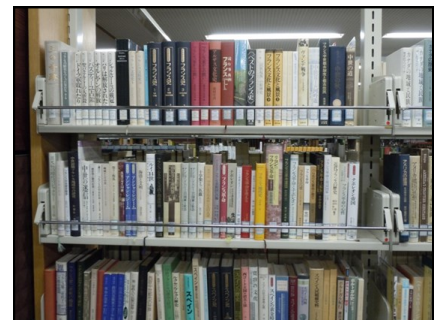
【対策③：耐震装置 (作動したところ)】
